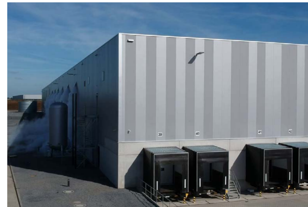
Het gebouw is voorzien van 76 laaddocks, die bewust buiten zijn gevestigd zodat er binnen meer ruimte overblijft voor andere doeleinden.
